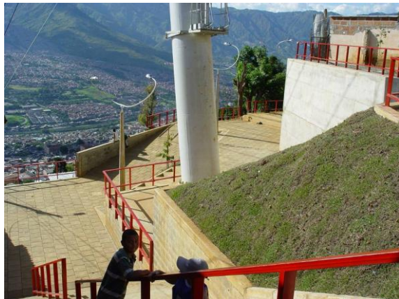
Foto 43. Acceso peatonal en la Comuna Nororiental después de la intervención urbana.
