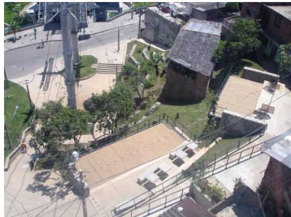
Foto 38. Parque Balcón del Ajedrez después de la intervención urbana.
