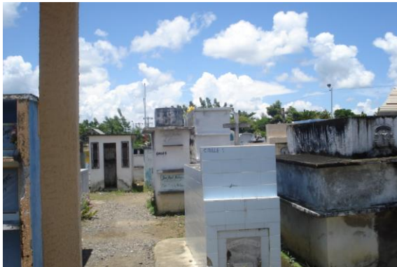
Foto 27. Estado del cementerio.
