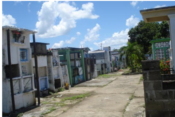
Foto 28. Estado del cementerio.
